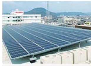
オフィス屋上
