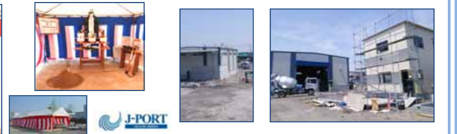
施工中の様子
